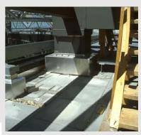
Hauptträger mit angeschweißten Stehbolzen und umlaufender Verblechung zur Aufnahme der Abdichtung
