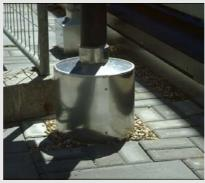
Stütze eingedichtet und mit Aluminium verkleidet
